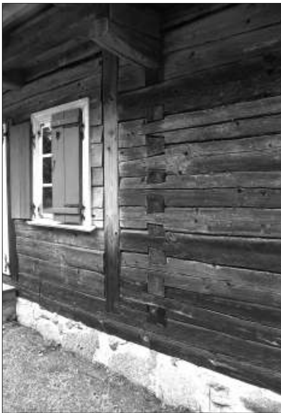
Sienoj sujungimui naudojama švilin stulpin konstrukcija
