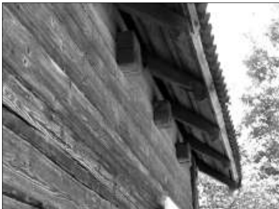
Profiliuoti stubos gegni galai. Dumiai k. Vilkaviškio r. LKa įskaita 2007 m. nuotr.
