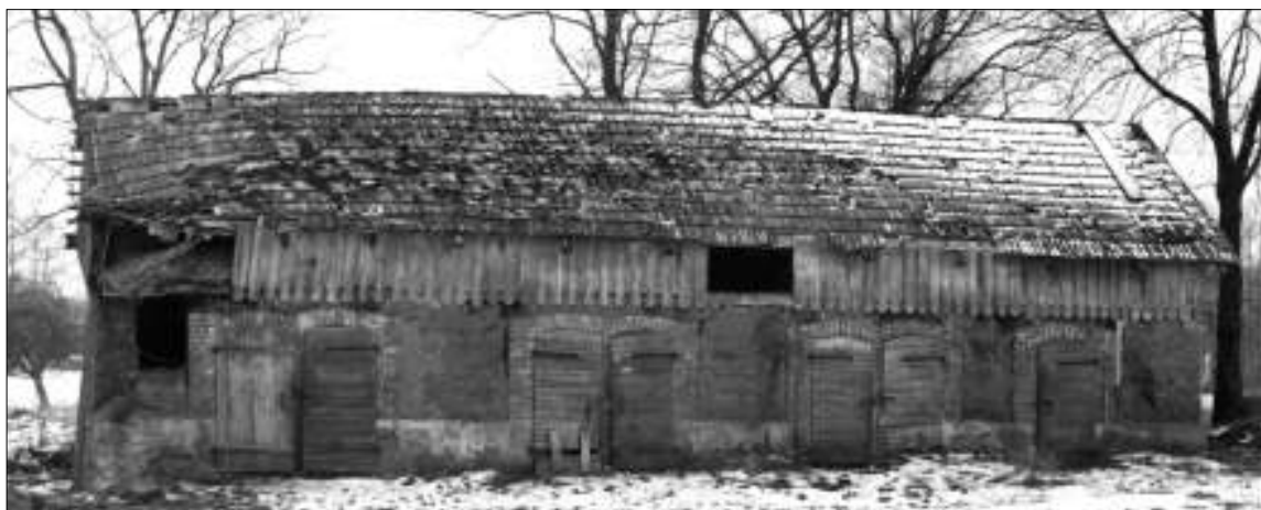
Dekoruota ertikio apaia: lent galai užapvalinti, taip sudaromas ištisas „bangel s” ornamentas. Tvartas Ži r -Gudeli k. Vilkaviškio r. KPC
