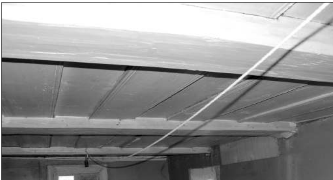
Vožtinės lubos leistos dalį balkio šeimynstubėje. Lubos lentos puošiamos griovelio formos ornamentais. Mieleiškampio k. Prien r. LKa inskait s 2007 m. nuotr.
