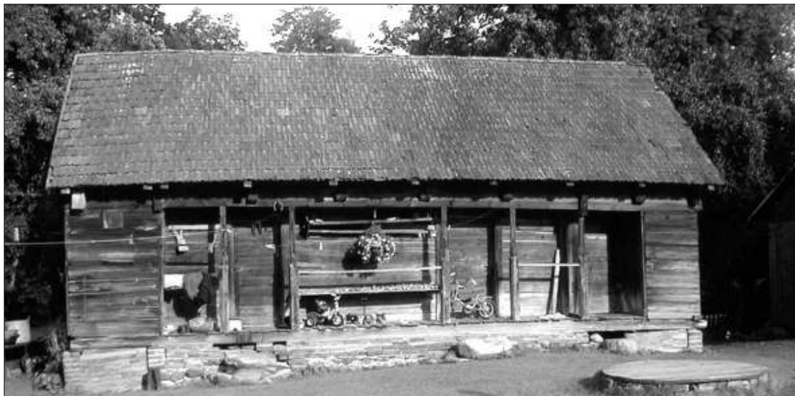
Klėtis su priekliu, kurioje ne tik šoninės klėties sienos, bet ir siauros šoninės patalpos – „antai“ – prat siamos per vis prieklio plotą. Naudži k. Vilkaviškio r. D. Ambrasaitis 2005 m. nuotr. VKM
