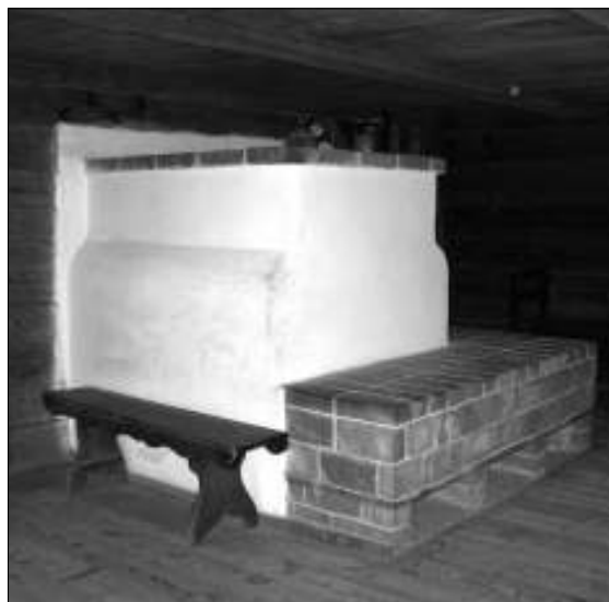
Prie stubos pe iaus vieno ar dviej šon rengiamas iš plyt išm rytas paaukštinimas – šiltas suolelis, vadinamas „zelikiu” arba „prydu”. LLBM
