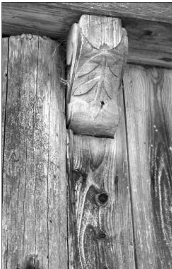
Stubos išilginis sienos iškyša – konsol, remianti skydą. Naudži k. Vilkaviškio r. LKa įskait s 2007 m. nuotr.
